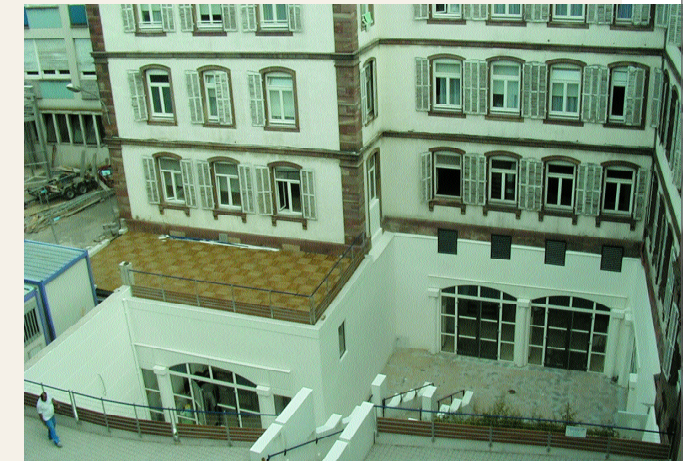
Cour Anglaise et fenêtres du restaurant.
