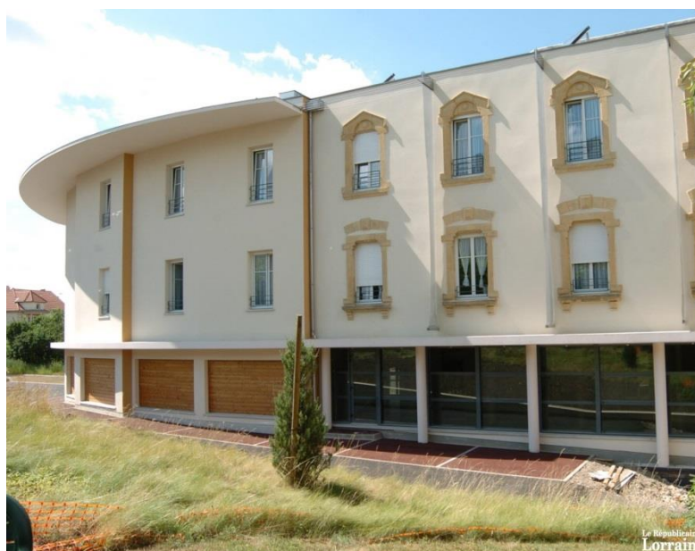
L'aile de la Fondation Vincent-de-Paul a été livrée en juillet 2010. Photo RL.
