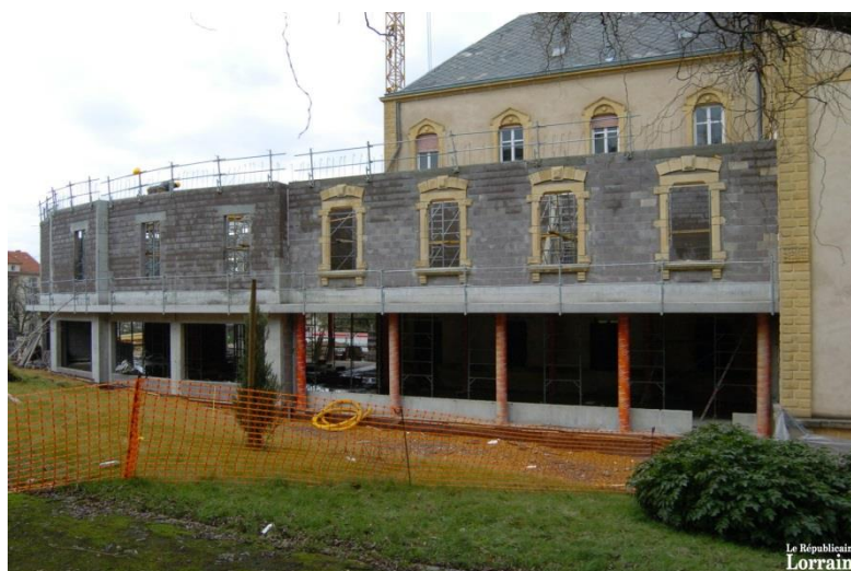
La restructuration de l'aile du bâtiment, en février 2009. Photo RL.
